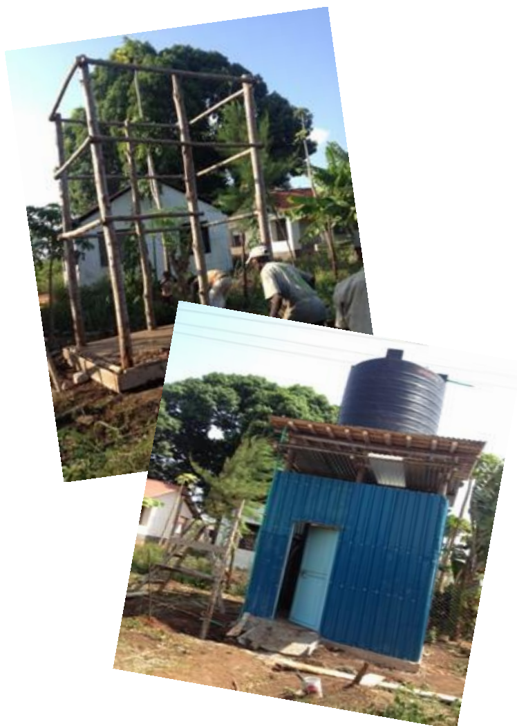
Foto: Bouw watertank en opslagruimte
